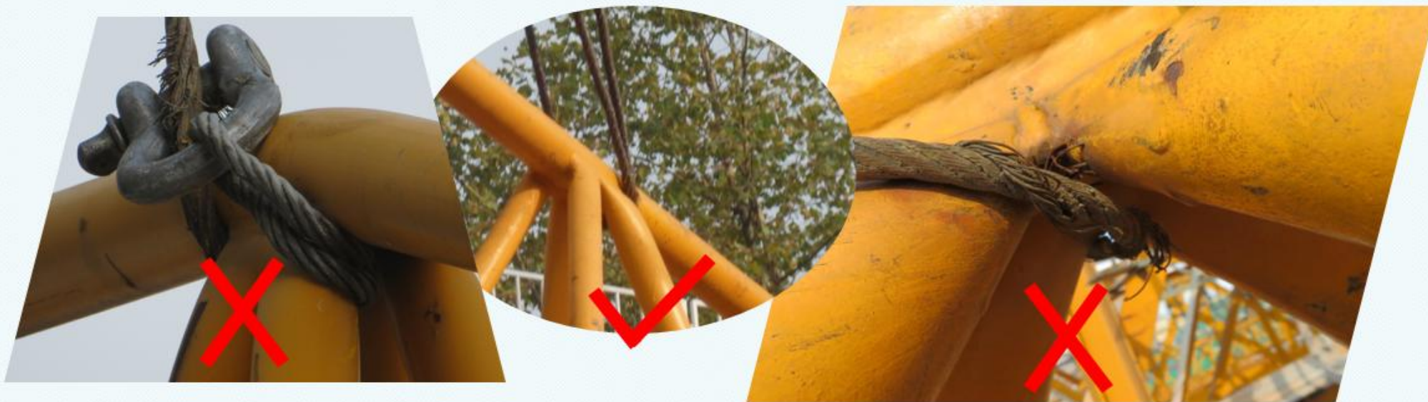
工作中实际吊装起重臂时钢丝绳的悬挂点选择
